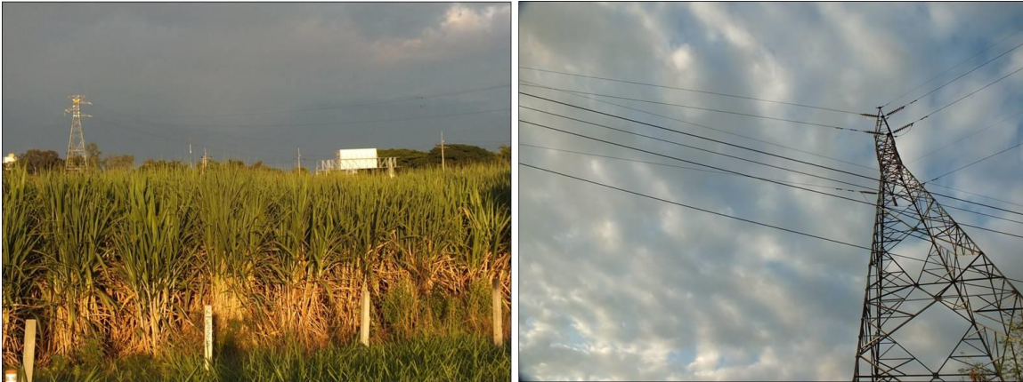
Imágenes de las torres y líneas eléctricas en la zona aledaña al impacto
